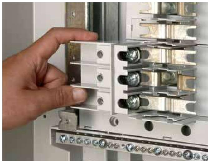
En los tableros con barras de 125 A, el Interruptor Principal (EASYTIKER hasta de 100 A) o el kit de Zapatas Principales para 125 A (cód. BFL125K) se “anidan” en el interior lo que permite colocarlos en la posición más conveniente para la instalación del tablero.
